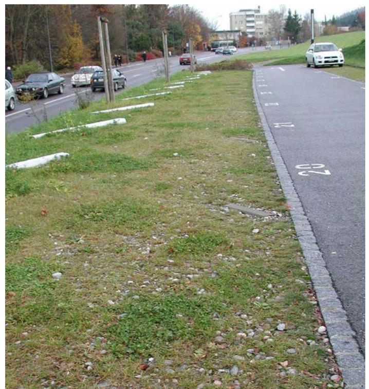
Illustration 4: Détail de la fonction du gazon-gravier et des bancs de gravier (à gauche); exemple d'une place de stationnement à base de gazon-gravier (à droite)
