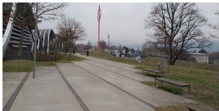
Illustration 6: Détail de l'infiltration dans les bas-côtés (à gauche) et d'un chemin piétonnier depuis lequel les eaux pluviales sont déversées dans une bande de gazon, où elles peuvent s'infiltrer en surface (à droite).
