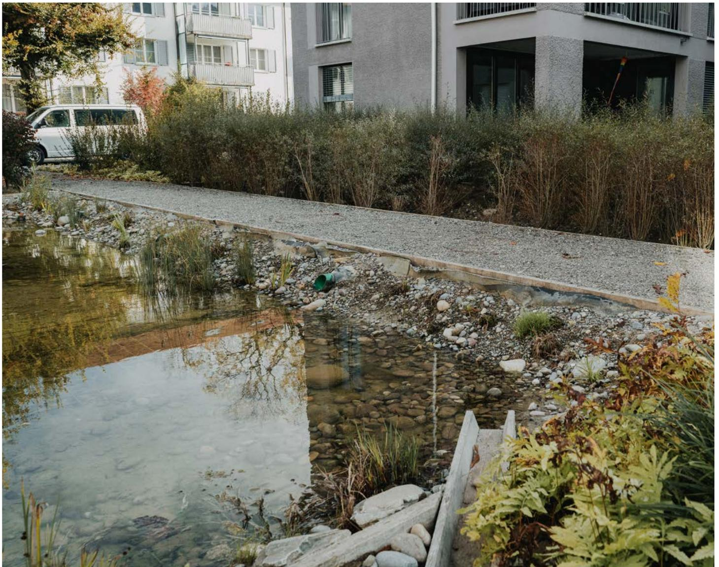
Illustration 2: Bassin de rétention intégré dans l'aménagement des abords avec déversoir (tuyau vert) donnant dans un bassin d'infiltration de l'autre côté du chemin
