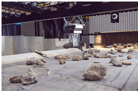
Installation de tri des déchets EbiMIK de l'entreprise Eberhard Recycling AG
