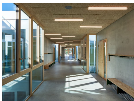
Béton avec granulats recyclés dans le bâtiment scolaire de Gebenstorf
