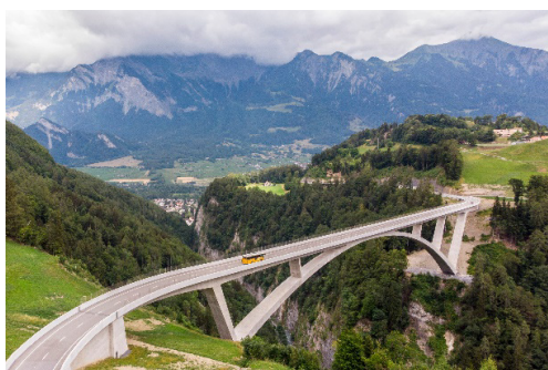
Pont routier de la Tamina (St. Galler Tagblatt.ch)
