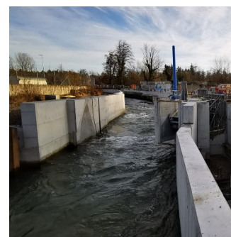
Béton porteur comprenant des granulats LAFE (laitiers d'aciérie électrique), utilisé pour rehausser les barrages hydrauliques
