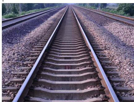
Rails et traverses en béton
